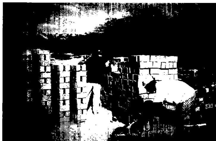
Colocación de ladrillos en horno postizo
