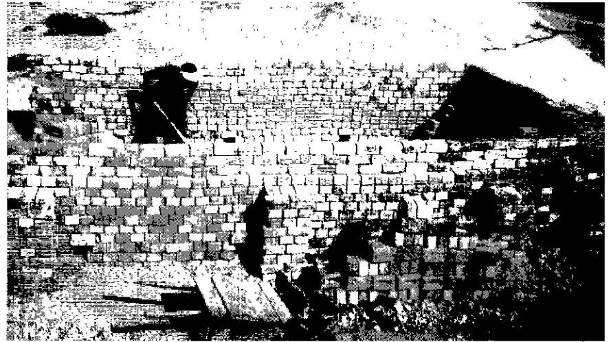
Limpieza de horno postizo
