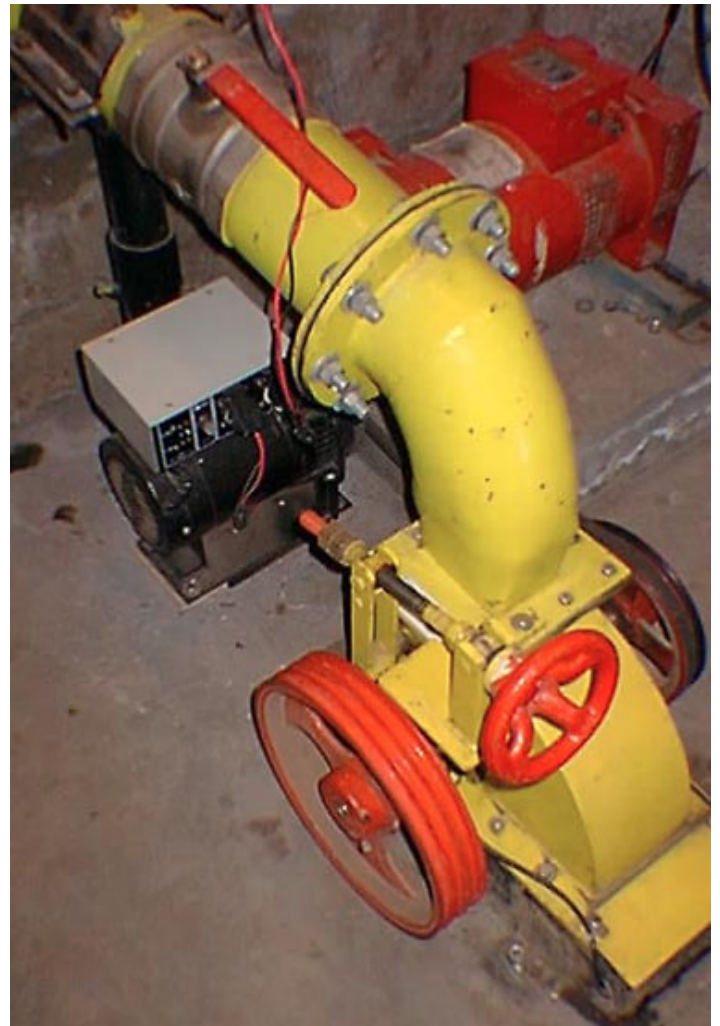
Foto 1 y 2: Regulador de frecuencia inteligente para microcentrales hidráulicas y su puesta en funcionamiento.
