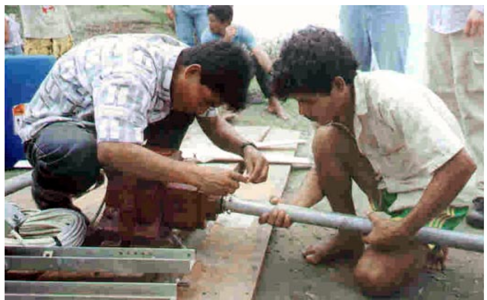
Foto 2: Equipo donado por TES, montaje del generador
