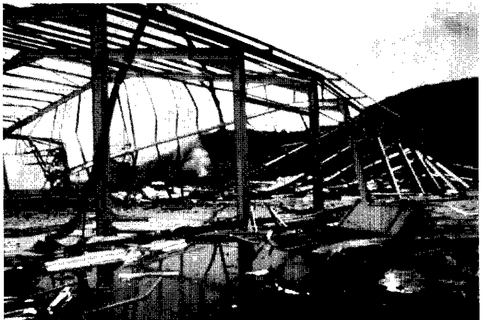
Figura 2.21: Colapso total de un cobertizo de plátanos en Dominica después del huracán David en el punto de agua Roseau (1979). Foto T. Gibbs.
