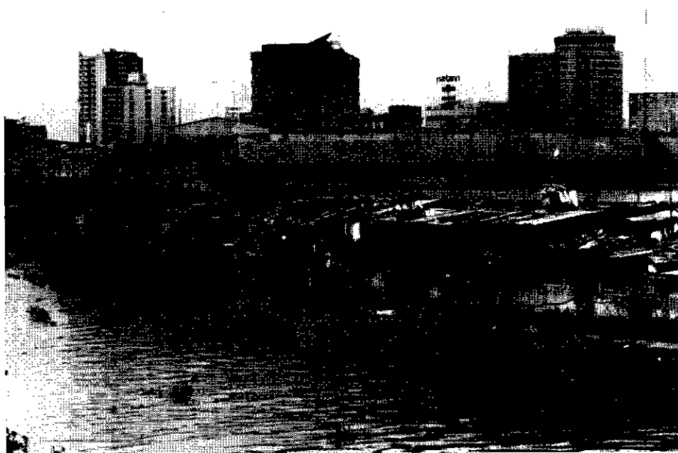
Figura 13.1: Estructuras de concreto armado de mediana y gran altura están brotando en el perfil urbano de la mayoría de las ciudades del mundo en vías de desarrollo (Manila, Filipinas).
