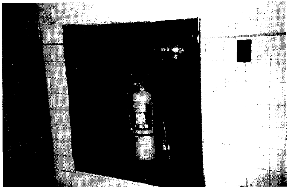
Figura 12.8: Condición del sistema de protección contra incendios.
