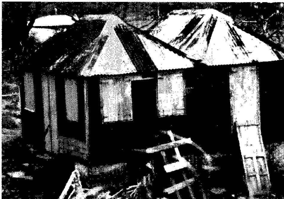
Figura 2.16: Una casa "chattel" en Montserrat que no fue afectada por el huracán Hugo (1989). La forma del techo minimizó la fuerza del viento sobre su frágil estructura. Foto: T. Gibbs, Barbados.
