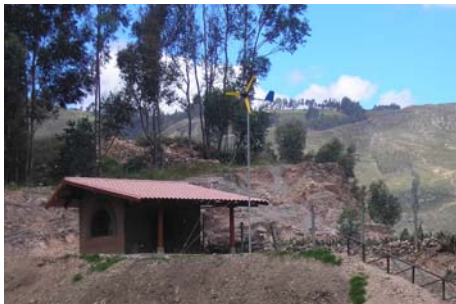
Modulo de Energía Eólica
