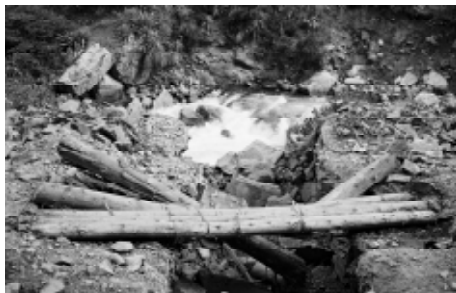
Puente rústico afectado por avalancha en Apurímac
