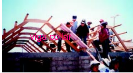
Construyendo una vivienda con viga collar sobre las paredes
