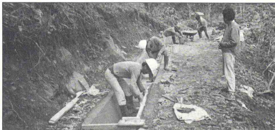
Revestimiento de un canal usando el método de la sercha .
