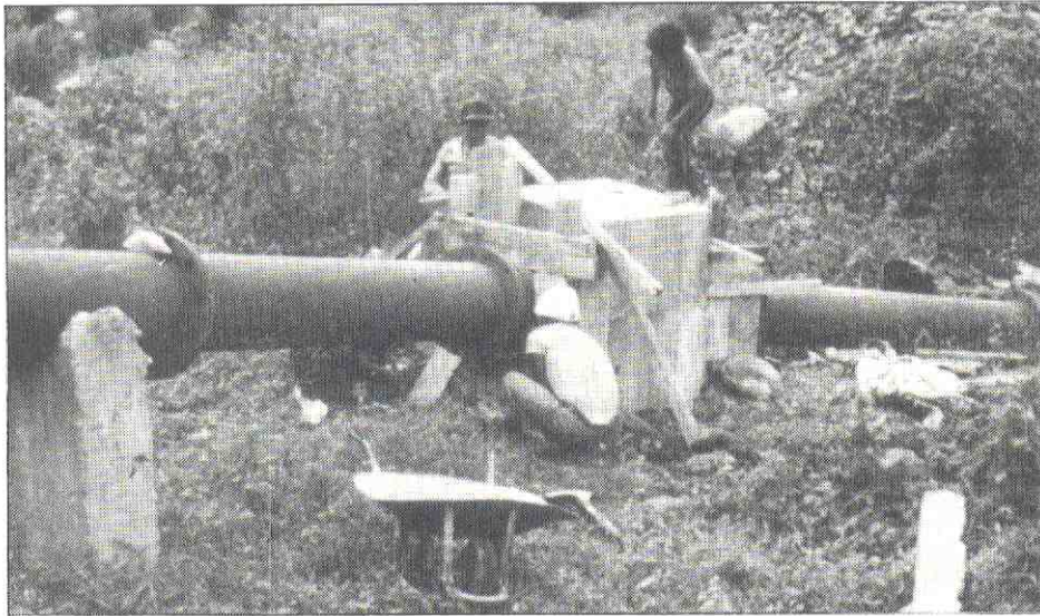
Reforzando bloques de anclaje de concreto armado de la central de Monte Salgado de 60 kW en el Perú.
