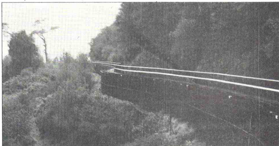
El canal de madera conduciendo agua desde la toma del dique en el río Arredondo.
