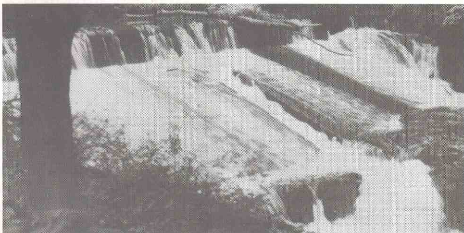
Dique de una PCH en Sajonia construido alrededor de 1930. Los peces migrantes están impedidos de alcanzar los lugares de desove.
