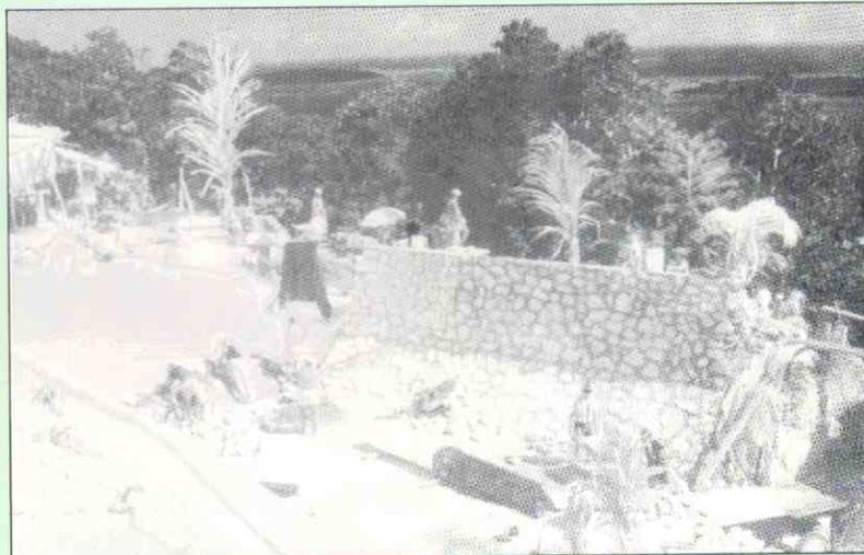
La pared de piedra del reservorio de acumulación para una minicentral hidráulica de 150 kW en las Islas Salomón en proceso de construcción.
