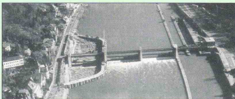
Vista aérea del proyecto Karlstor en Alemania.
