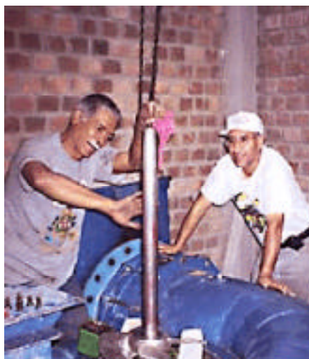
Foto 1: Montaje de turbina axial de 25 kW, Las Juntas, Perú
