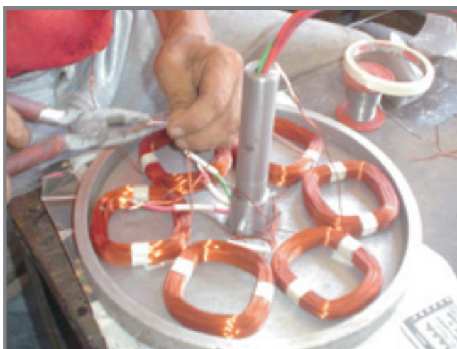
Foto N° 10: Seis bobinas en molde, empalmes con cinta aislante y ubicación del eje hueco. Fuente: Soluciones Prácticas – ITDG.
