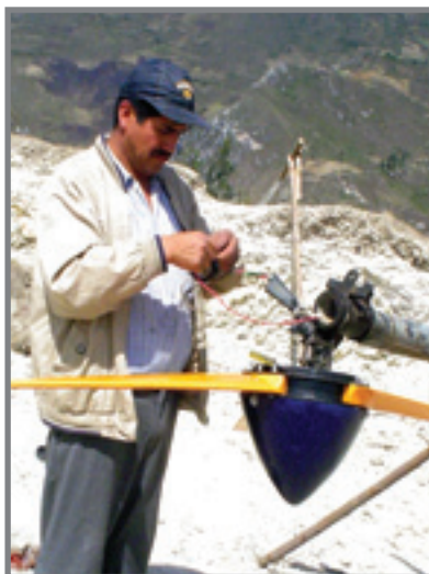
Foto N° 36: Empalmes de conductores eléctricos. Fuente: Soluciones Prácticas – ITDG.
