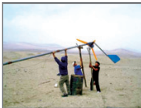
Foto N° 37: Una forma de izamiento del poste Fuente: Soluciones Prácticas – ITDG.
