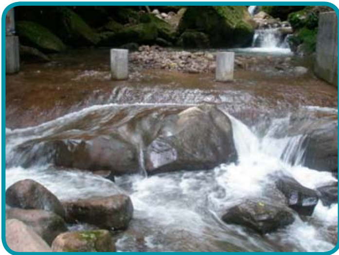
BOCATOMA DE BARRAJE MÓVIL
